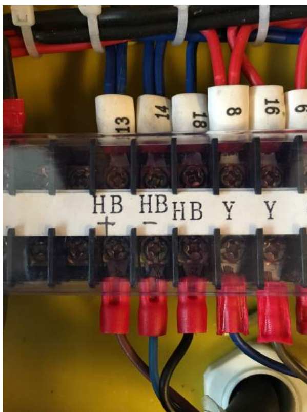
Fig. 12 – Tilslutning af fotosensor i kontrolpanelet
