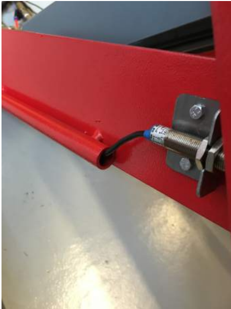
Fig. 8 - Montering af topsensor på autolift
