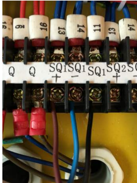
Fig. 9 - Tilslutning af topsensor i kontrolpanel
