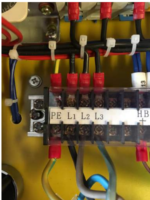
Fig. 13 - Tilslutning af 380V
